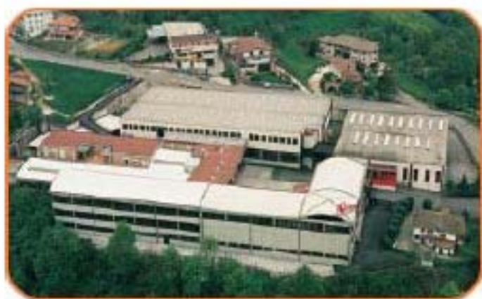
位于Lumezzane的主要生产车间 The main production unit in Lumezzane
